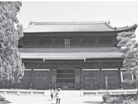
東福寺の本堂、日蓮柱は本堂内の右側の隅にある
