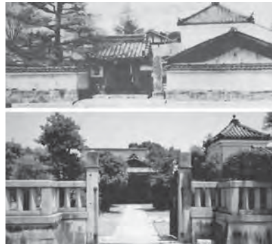
（上の写真）旧宥清寺（現在の佛立霊地）高祖600回御遠諱の大法要は、この旧宥清寺で一座のお看経がなされた。（下の写真）宥清寺の向かい側に明治十三年に建てられた本門佛立講親会場（現在の佛立教育専門学校）では御法門が説かれた。
